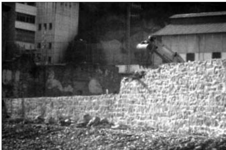
Una excavadora derriba parte del muro de la antigua fundición de Pinaquy
