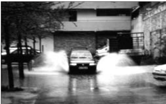
Quando llueve el solar se inunda y presenta este aspecto
