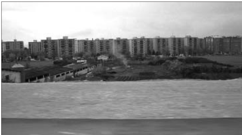
Las 1.400 viviendas se construirán en terrenos de la Txantrea y de Ansoáin
