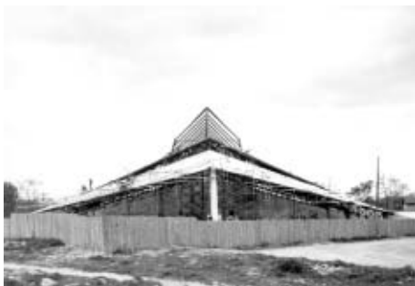
Imágenes de la construcción de la Parroquia de Santiago.
